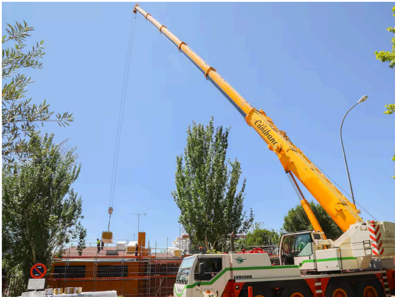
Obras en el CEIP Federico García Lorca de Alcobendas
