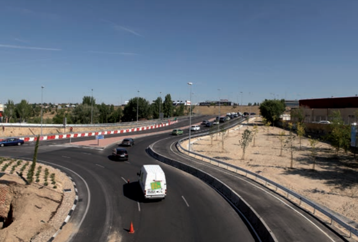
Ramal directo desde la carretera de Fuencarral hacia la A-1, abierto recientemente.
