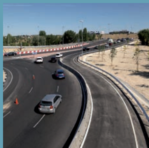
Finalizadas las obras del 'Nudo de Valdelaparra'
