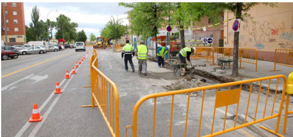
Obras en la calle Isaac Albéniz de Alcobendas / Ayuntamiento de Alcobendas
