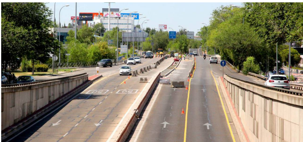
Obras de acceso al Paseo de la Chopera desde la A-1 / Ayuntamiento de Alcobendas
